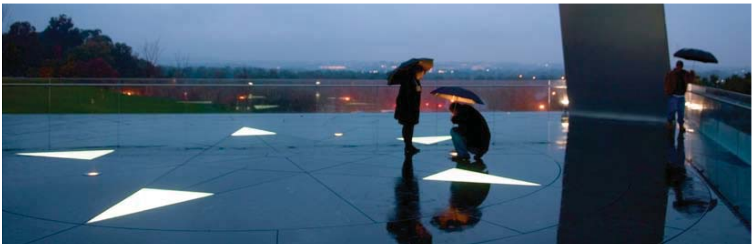
Der Luftwaffenstern im Boden zwischen den aufstrebenden Spitzen wird aus Glasplatten gebildet, die in den Granitboden eingebettet sind. LEDs beleuchten diese Anordnung
